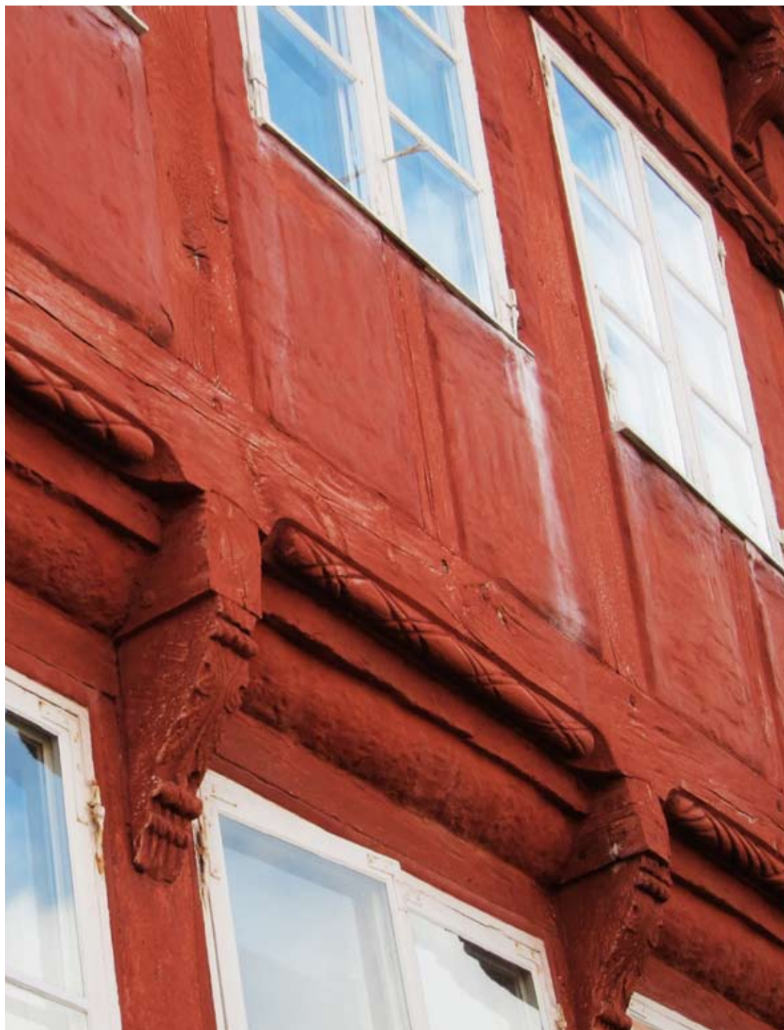
Bindingsværket på det velbevarede renæssancehus i Adelgade 17 i Kalundborg er et eksempel på den håndværksmæssige variation og detaljerighed, som de fredede bygninger rummer. Schous Hus, som det kaldes, er fra begyndelsen af 1600-tallet. Foto: Kulturarvsstyrelsen.
