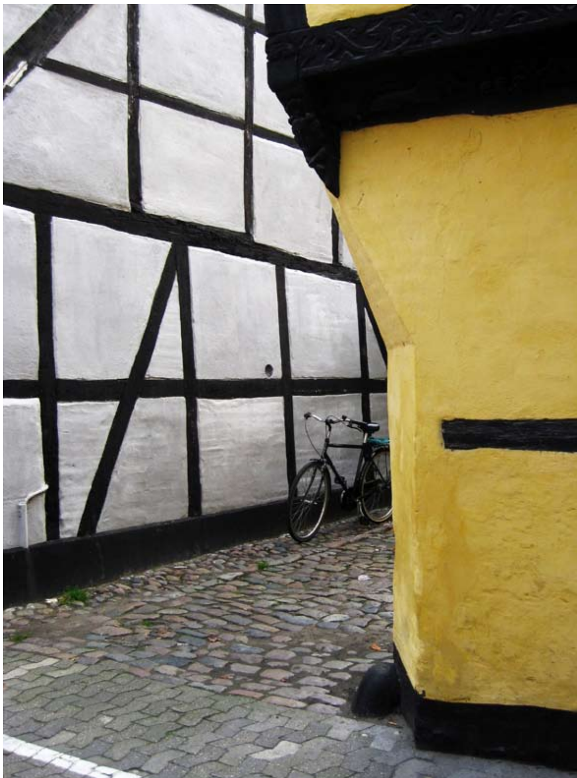
Fredningsgennemgangen er i Guldborgsund Kommune. Her kan man blandt andet se en meget karakterfuld facade i Frisegade 1, Ritmestergården i Nykøbing Falster - den gule bygning i forgrunden. Foto: Kulturarvsstyrelsen.
