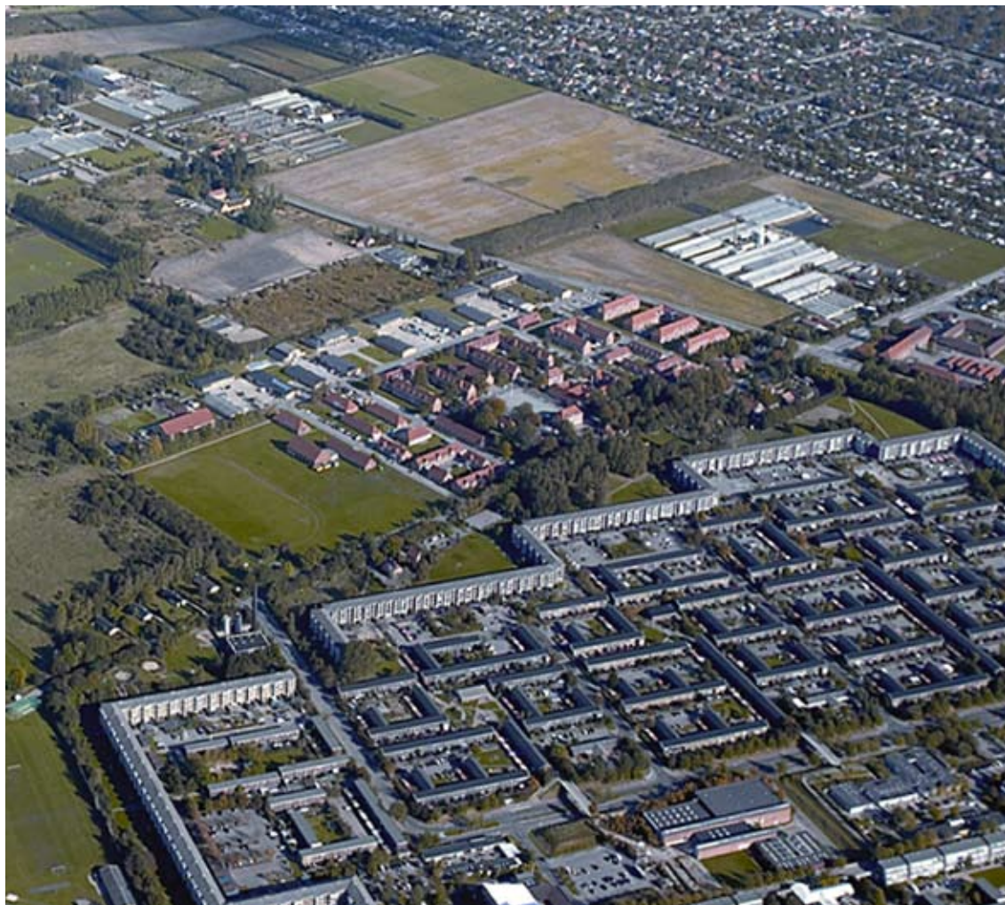
Avedørelejren havde en optimal beliggenhed for genanvendelse – tæt på stationen og med grønne områder 'i baghaven'. Bebyggelsen er markant anderledes end de tilstødende områder fra nyere tid, men der var bred forståelse for, at genanvendelsen af Avedørelejren ville give kommunen et kulturelt og socialt løft. Foto: Hvidovre Kommune.
