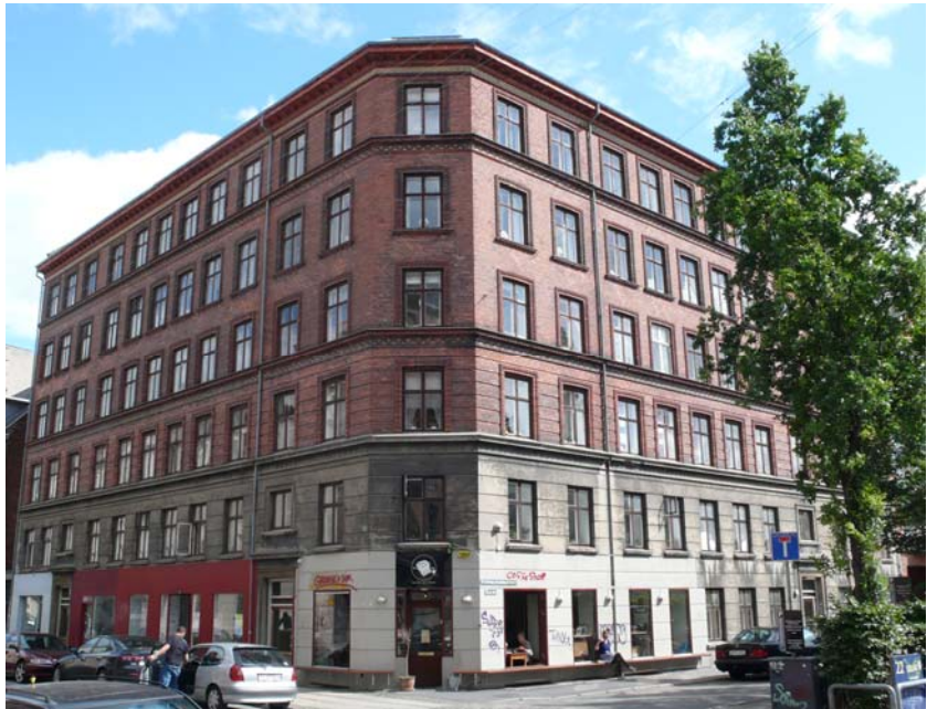
Ryesgade 30, hvor der er udført prøvelejlighed og skal gennemføres samlet energirenovering "bag facaden"
